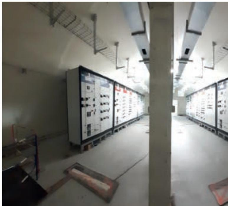
Tableaux généraux basse tension, cheminement de câbles et système de climatisation en station technique
