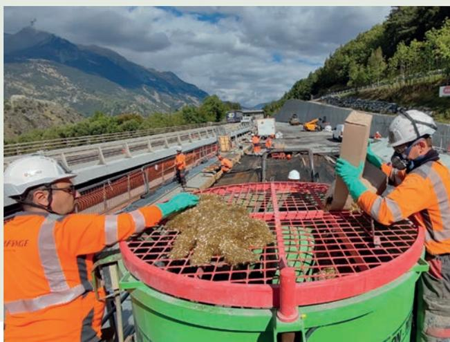
Fabrication du béton fibré ultra haute performance
