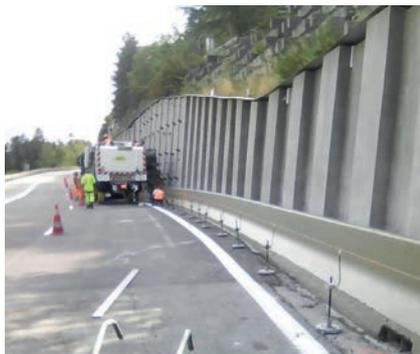
Coulage glissière béton armé (extrudé)
