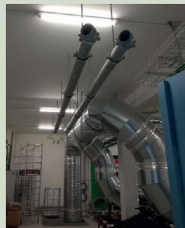
*Climatisation et circuit d'eau glacée dans la station technique ST-2-01-20 sur la plateforme française*
