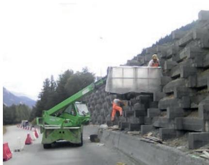
Piquage du béton altéré avant réparation
