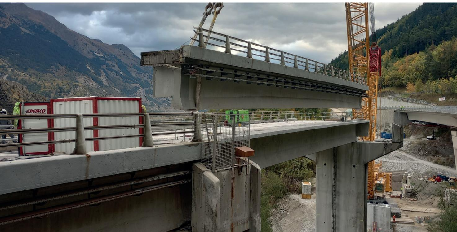
**Les travaux de génie civil se sont poursuivis au printemps 2023** (réalisation des raccordements des chaussées lors de la fermeture du tunnel du Fréjus en avril 2023, mise en place des dispositifs de retenue, assainissement), ce qui a permis de mettre en circulation le nouveau viaduc le 26 juin 2023.
