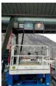
En mars 2025, deux voies tests ont été mises en place, pour une durée d'un mois, sur la borne d'entrée 02 et la voie de sortie 053 de la barrière de péage de Saint-Michel-de-Maurienne. En suivant, le déploiement des FAV sur l'ensemble des gares de péage (36 voies au total) a été réalisé (tirage de câbles et pose des FAV) en cohérence avec l'avancée du marché de rénovation du péage et la mise en place des nouvelles bornes d'entrée.
