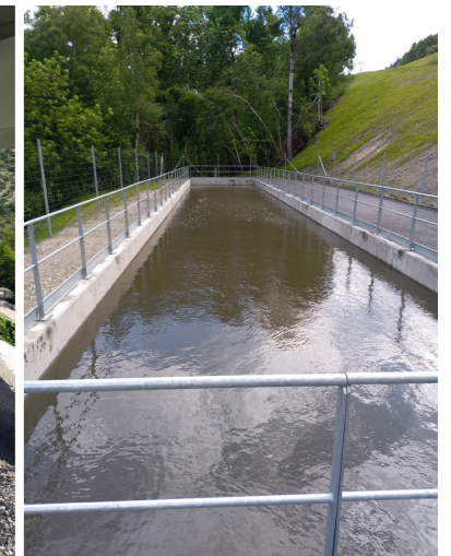
Bassin de rétention rive droite
