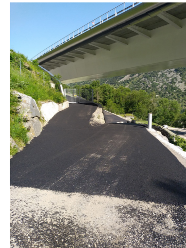
Revêtement des pistes
