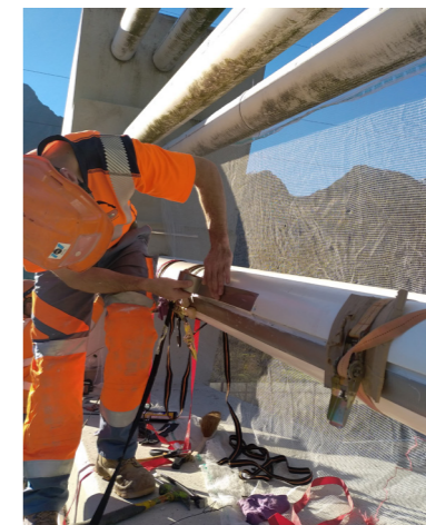
Mise en place de la nouvelle gaine en aluminium
