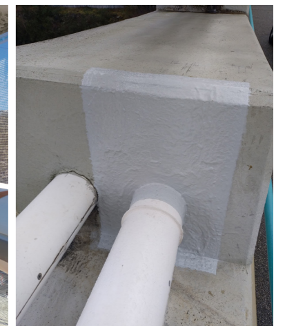
Réparation en résine pour l'étanchéité de l'extrémité de la gaine
